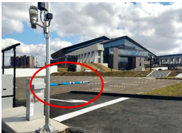
実証実験で使用している「折れずに“曲がる”新ゲートバー」
